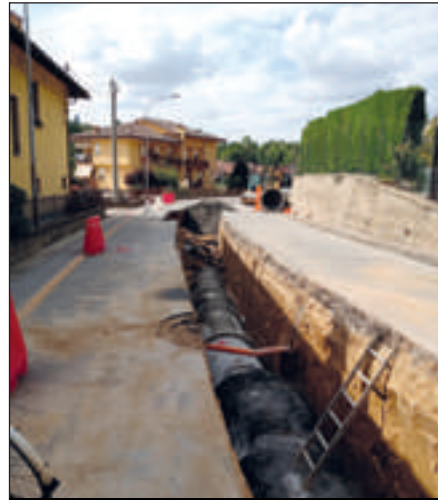
Scavi profondi in via Roma (lo dice la scala).
